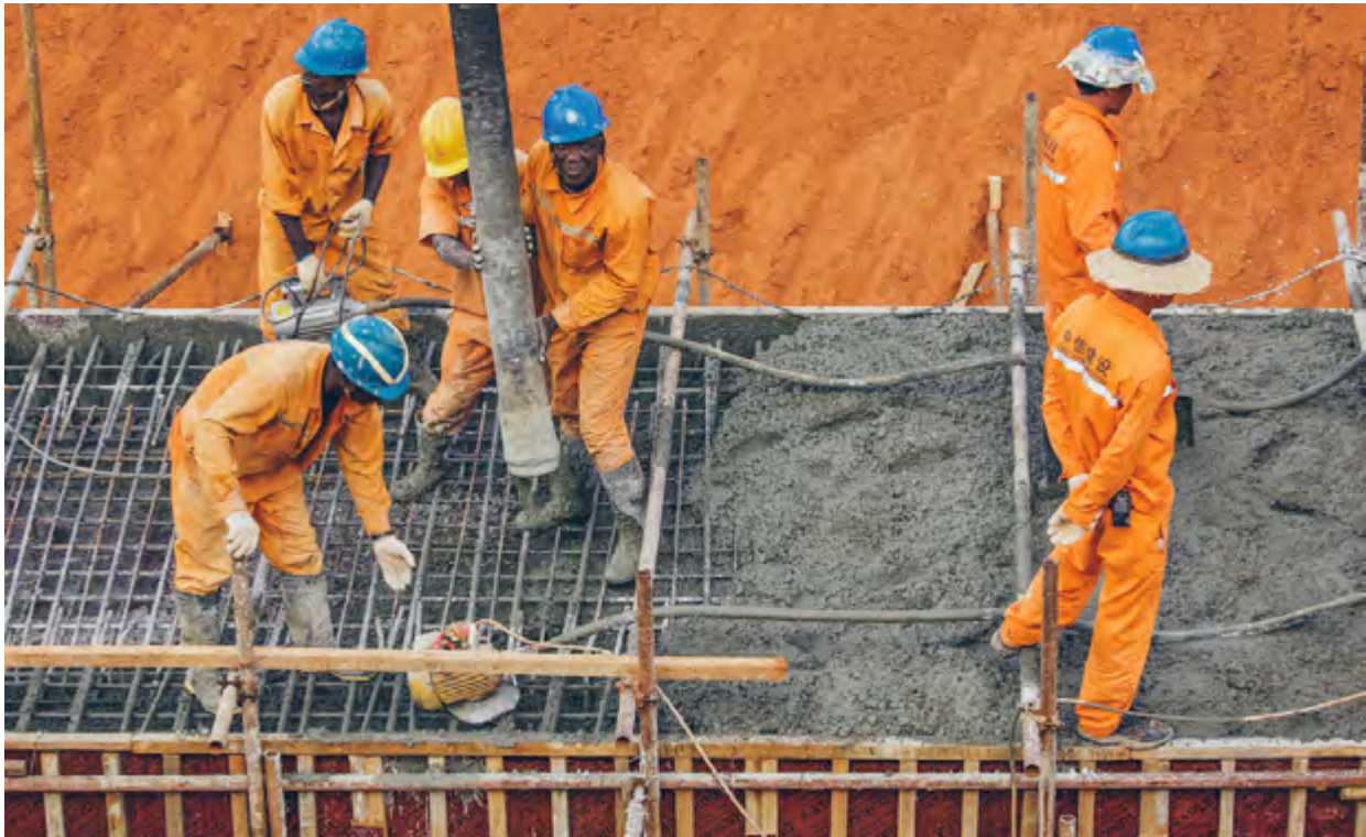
Figure 7 : La main d'œuvre locale sera privilégiée pour la réalisation des infrastructures
